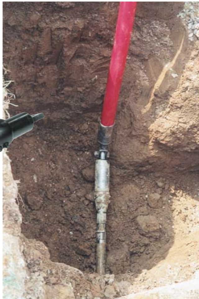
Les tubes peuvent être entraînés individuellement ou en faisceau
