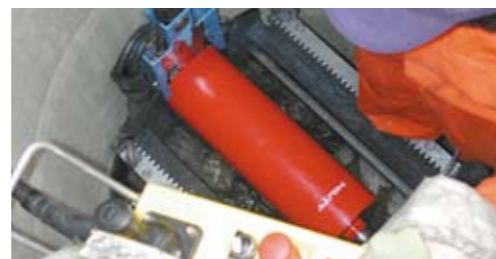
Grundopit réalise le forage d'un regard. Utilisation avec KA 38.
