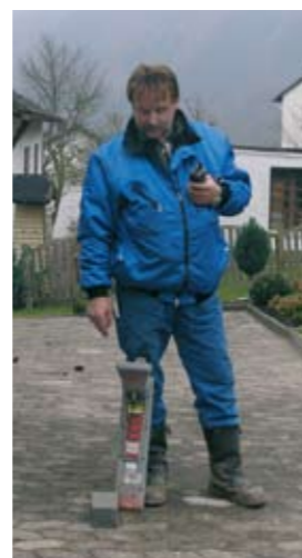
Détection de la tête de forage, arrivée et tirage du tube.
