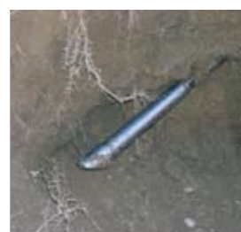
Détection de la tête de forage, arrivée et tirage du tube.
