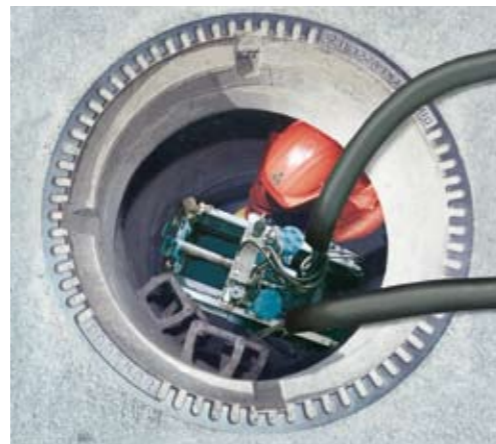
Démarrage du regard vers l'endroit d'alimentation de l'immeuble.
