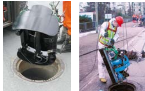
Mise en place de la plate-forme de travail et du Grundopit regard.
