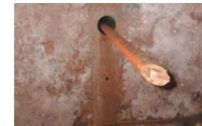
4. Entrée de la tête de forage dans la cave
