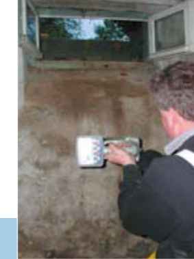
Réalisation d'un forage à travers un mur: 1. Détection de la tête de forage avant la paroi de la cave
