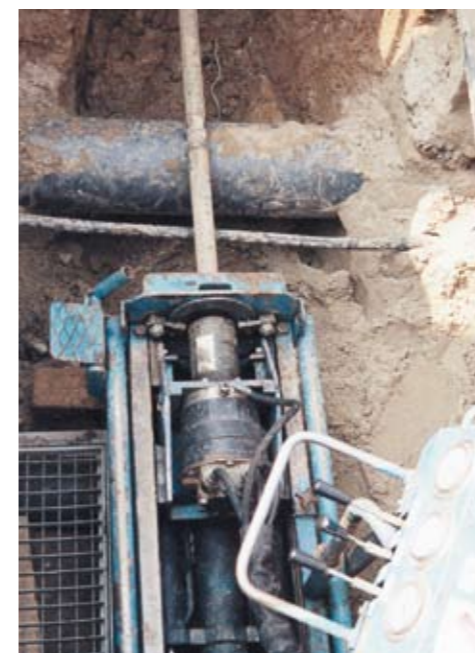
Marteau à percussion pour le forage à travers un mur en béton.
