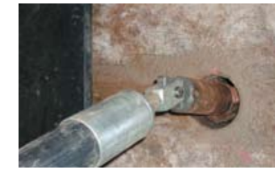
5. Changement d'outils/Entraînement du tube
