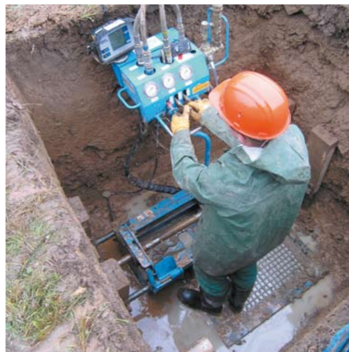
Détection de la tête de forage, arrivée et tirage du tube.
