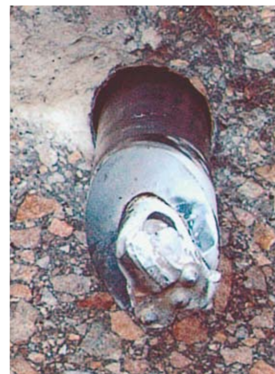
Marteau à percussion pour le forage à travers un mur en béton.
