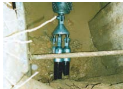
Les tubes peuvent être entraînés individuellement ou en faisceau
